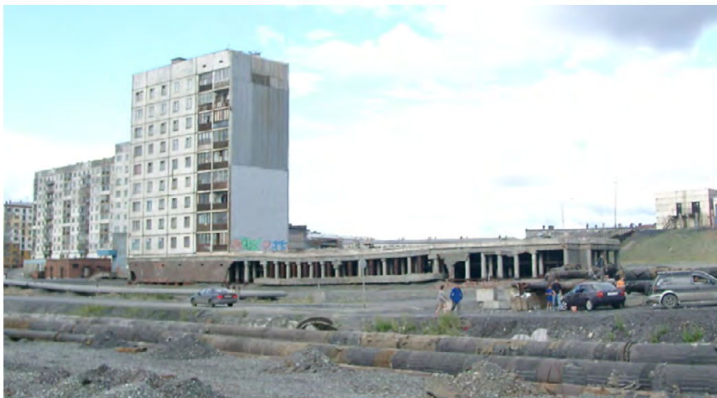
Рис. 4. Норильск. 2/3 дома разобраны из-за недопустимых мерзлотных деформаций
